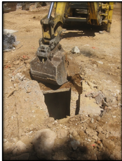
Foto 16. Desmuntatge de l'accés 2.
