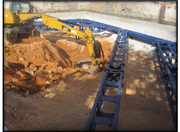
Foto 18. Treballs de rebaix.
