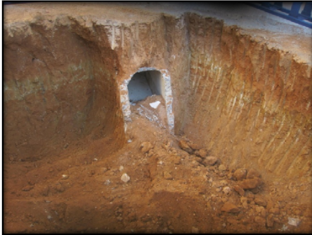
Foto 21. Detall de l'ús de maons en zones puntuals.
