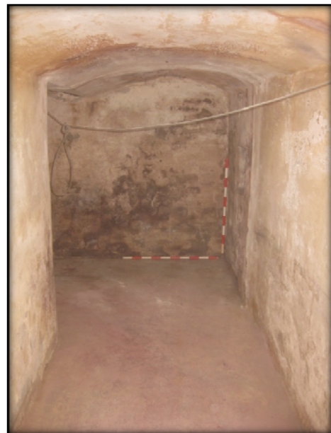
FOTO 4. Vista d'un tram del passadís ample a l'interior del refugi.
