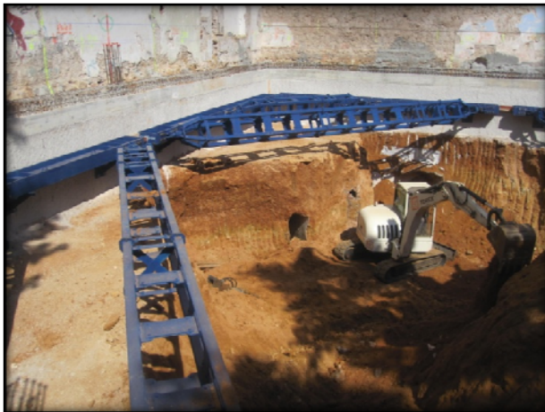
Foto 19. Treballs de rebaix.
