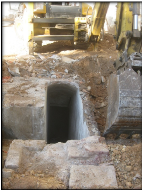
Foto 15. Desmuntatge de l'accés 1.
