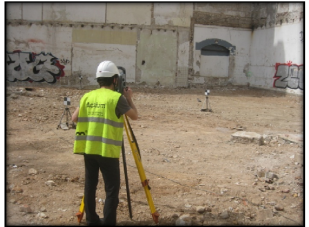
Foto 14. Treballs de topografia.
