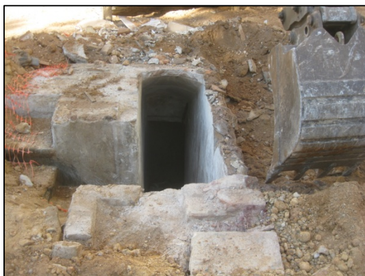
Vista del procés de desmuntatge dels accessos 1 i 2.
