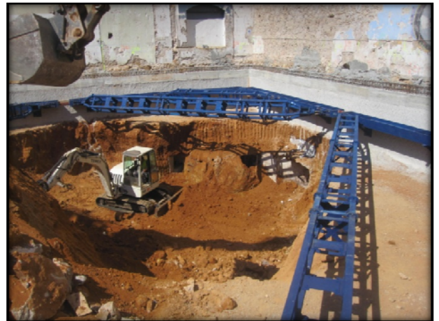
Foto 20. Treballs de rebaix.
