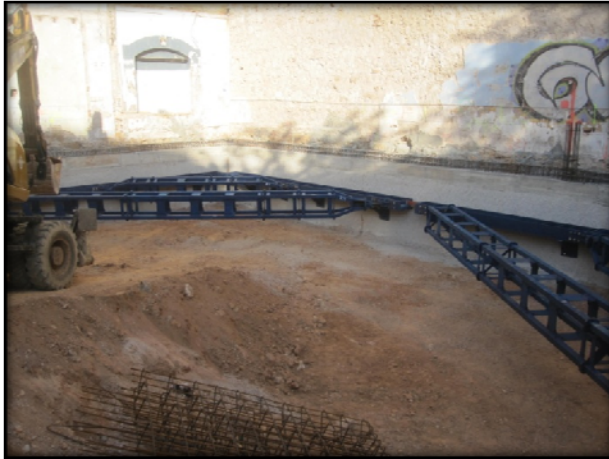
Foto 17. Inici del rebaix, una vegada feta l'entibació.
