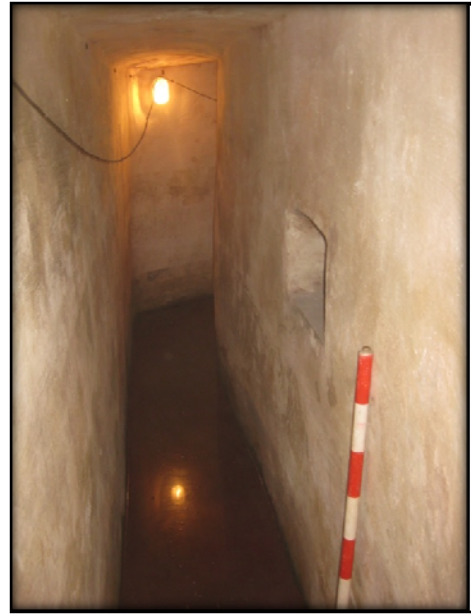
FOTO 6. Vista d'un tram del passadís estret
