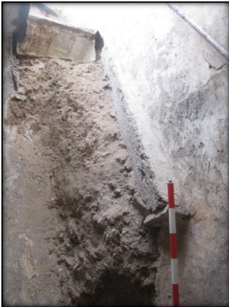
FOTO 11. Detall dels encaixos pel tram d'escala de fusta de l'accés 2
