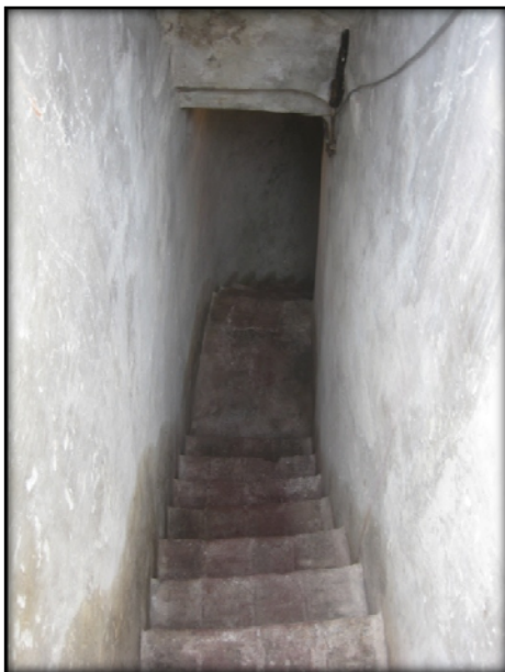
FOTO 3. Vista d'un tram d'escala de l'accés 1.
